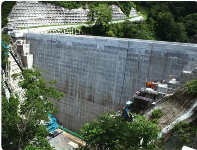
木戸ヶ沢貯水池保全施設の施工状況
