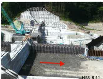
1号水質保全施設(工事状況)
