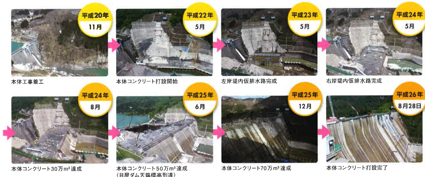
巡航RCD工法施工状況
