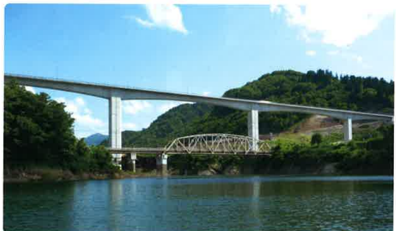
付替県道で一番長い砂子瀬橋
