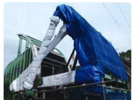
コンジットゲート(設置状況)
