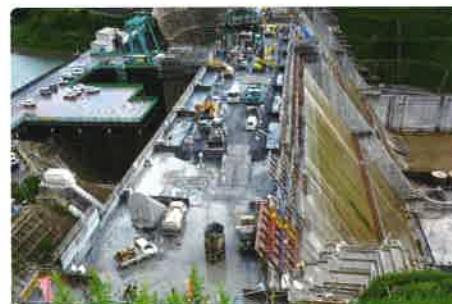
巡航RCD工法施工状況
