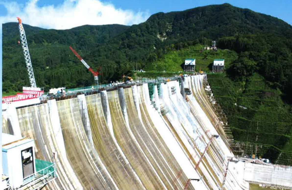
津軽ダム本体コンクリート打設が完了しました。(8月28日)
